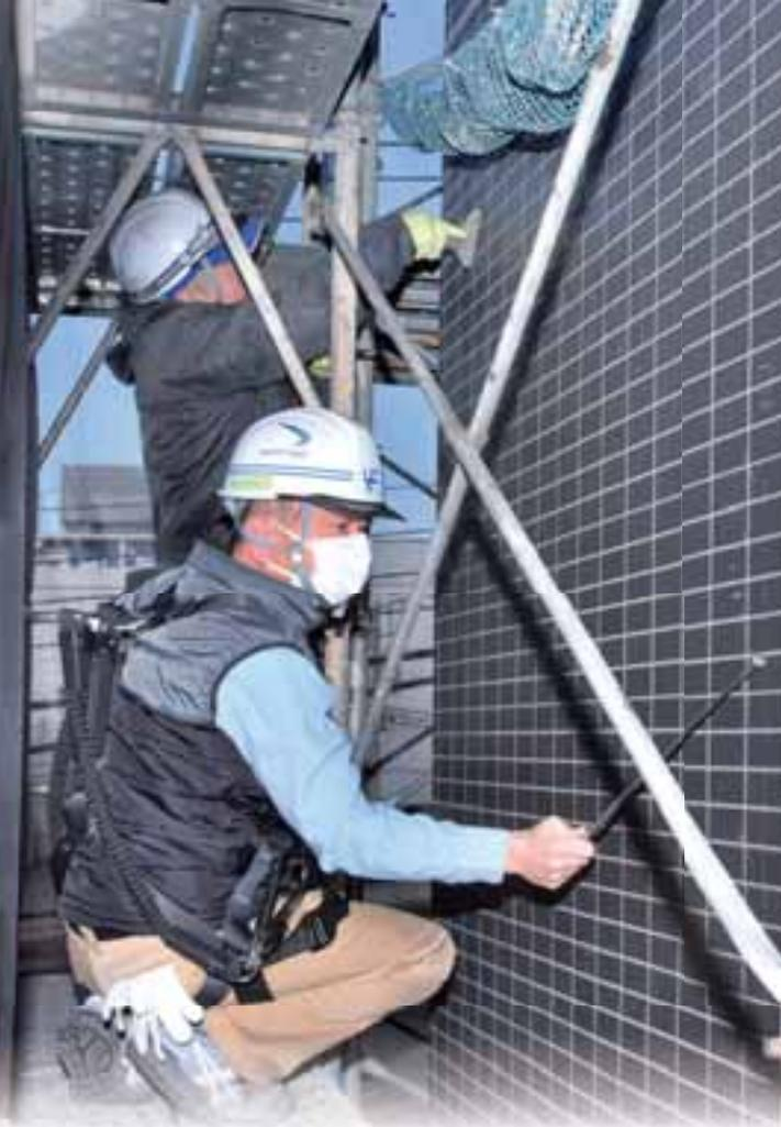
打診棒で施工を担当しているマンション外壁のタイルを叩き、反響音によって不具合がないかをチェックしていく。
