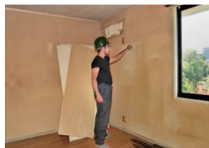
ボードをノックして、石膏ボードの位置を点検する高城社長
