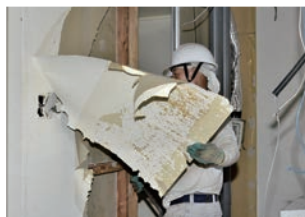
内装の解体はすべて手作業。危険も伴うため注意深く勤めていく
