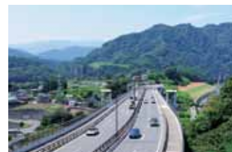
津久井広域道路は平成26年度完成予定の圏央道相模原ICへのアクセス道路でもあります
