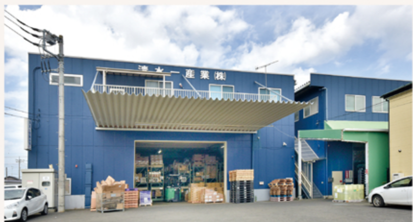
本社から500メートルの場所にある第二工場。生活雑貨、文房具、衛生用品などを扱う
