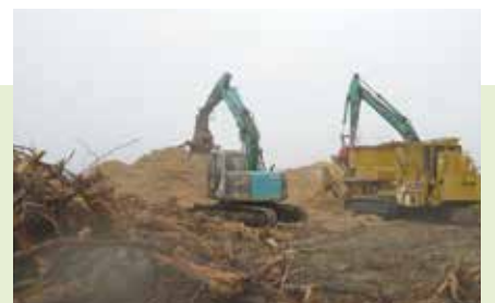
津波被害木を樹木破砕機(右)によってチップ化。現場での有効利用が可能
